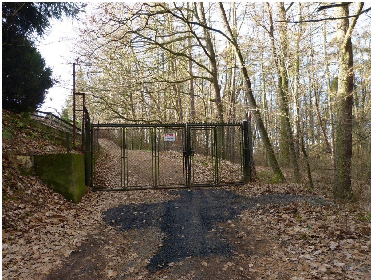
Oprava cesty u dolní brány asfaltem 10.12.2016
