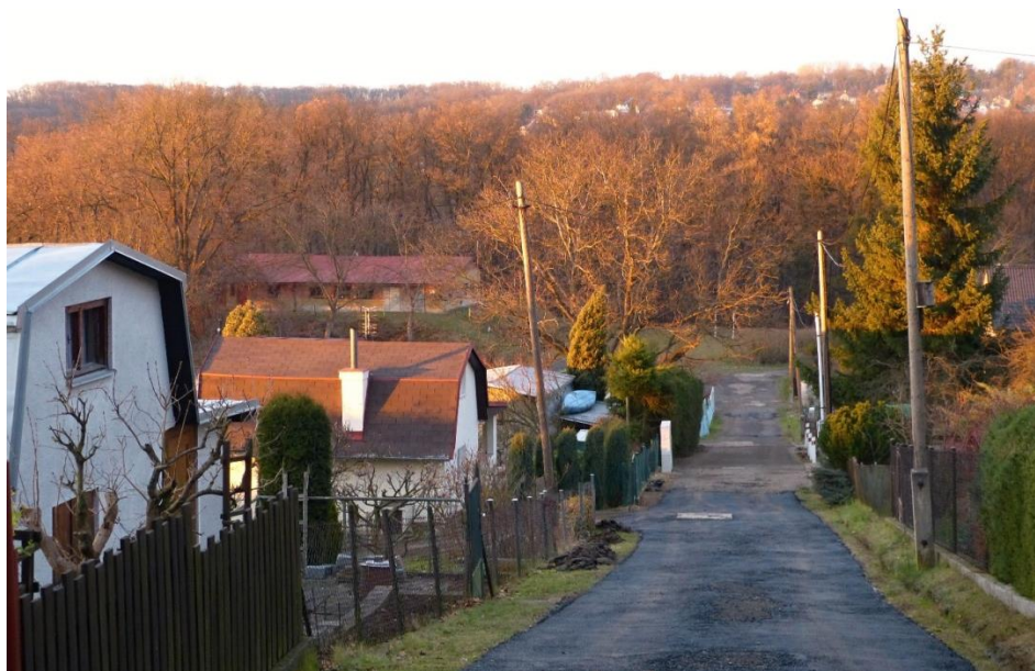
Celková oprava cesty asfaltem
