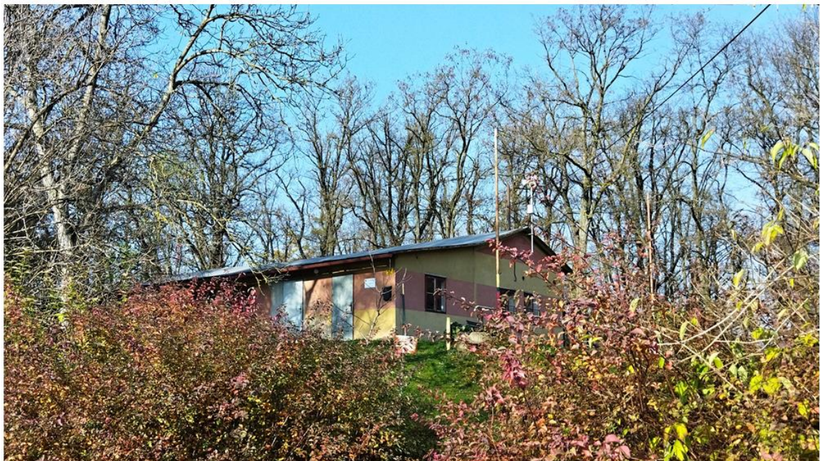
Výměna krytiny za novou lepenkovou dokončena Foto 14. listopadu
